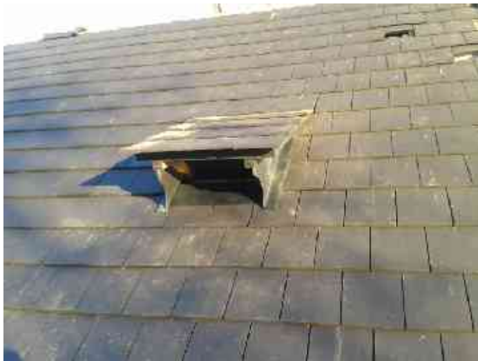
Secteur d'Abbeville (80) Création d'une « chiroptière » dans un comble d'habitation
